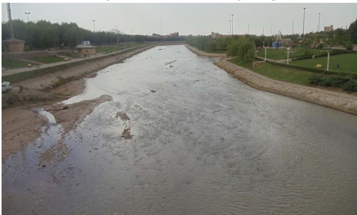
شکل شماره ۱۱: مستقیم‌سازی مسیر رودخانه و سنگفرش کردن بستر رودخانه
